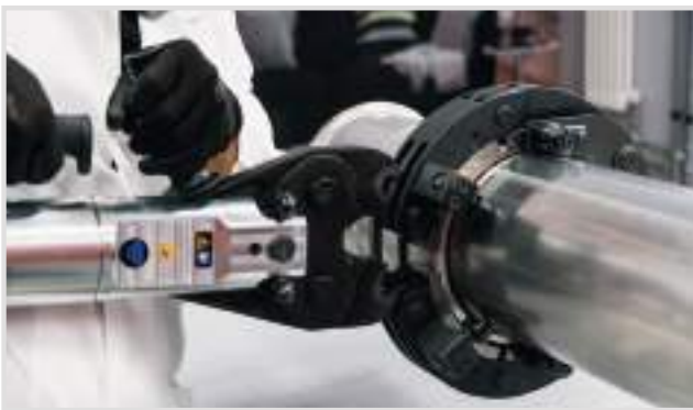
Assemblaggio pressatura n°1 / Press assembly phase 1
